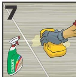
Limpie los residuos de adhesivo una vez terminada la instalación con una esponja o trapo húmedo. Remover el exceso de adhesivo en las juntas para tener por lo menos una profundidad en la junta de 2/3 disponible para emboquillar.
