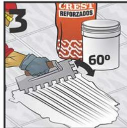
Inclinando la llana con la sección dentada en un ángulo de 60° de la superficie, en forma lineal sobre el adhesivo recién aplicado, evitando hacer rayado en forma de abanico.
