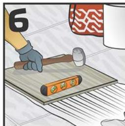
Golpear las losetas con un mazo de hule levemente del centro de la loseta hacia afuera para sacar el aire y asegurar su contacto con el adhesivo. Verifique la correcta nivelación de las losetas.
