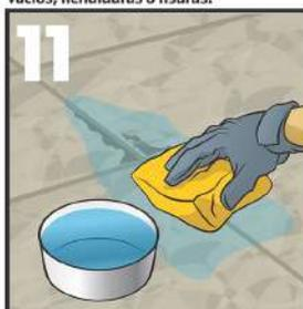
Con un trapo limpio o esponja húmeda, limpie la superficie de las losetas en forma diagonal al sentido de la junta, enjuagando periódicamente el trapo o esponja en agua limpia.
