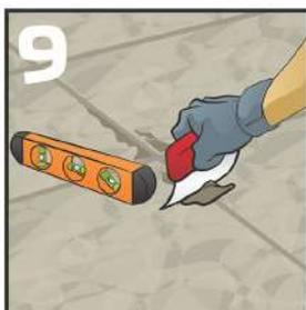
La superficie de JuntaCrest Ultramax puede ser nivelada o enrasada al borde de la loseta.
