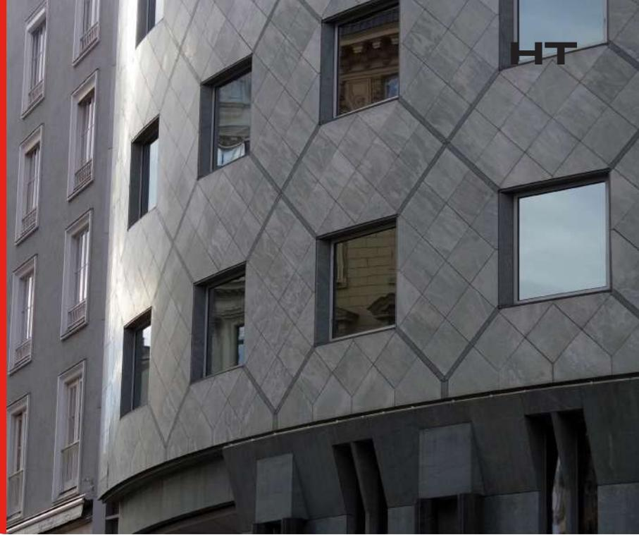
**Diseñado para instalarse en fachadas expuestas a cambios de temperaturas • Adhiere losetas cerámicas, porcelánicas y pétreas Cumple y excede ANSI A118.1, A118.4, A118.11, A118.15, NMX-C-420-1-ONNCCCE-2017 y ISO 13007 C2 • Nivelada y pega, corrigiendo hasta 3 cm de desnivel • Uso residencial y comercial • Uso interior y exterior**
